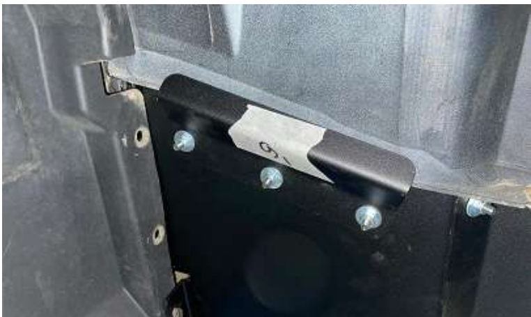
Закрепить штатное заднее крыло между панелями №2 и №9.
