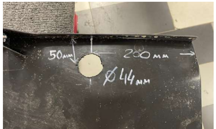
Просверлить отверстие 44мм
