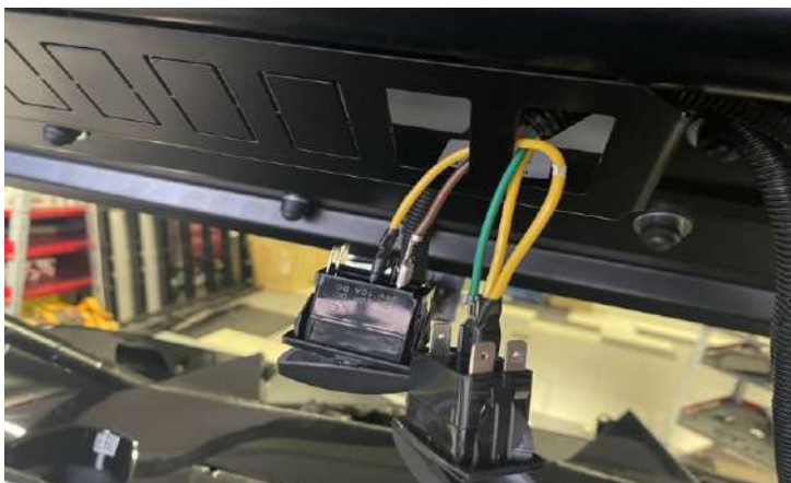
Подключить кнопки к проводке
