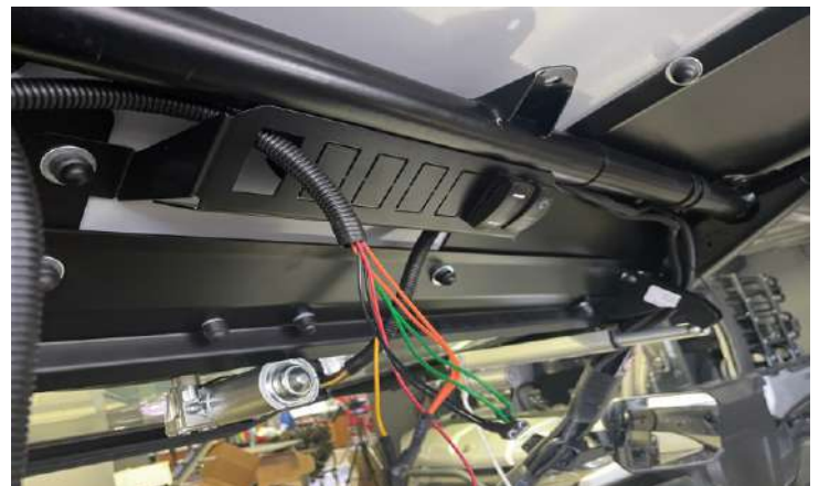
Протянуть конец электрической проводки через панель.
